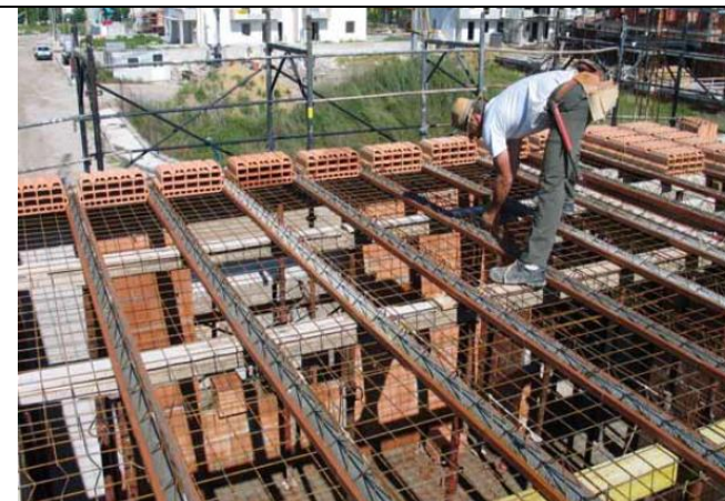
Utilizzo di reti elettrosaldate sopra le opere di banchinaggio
